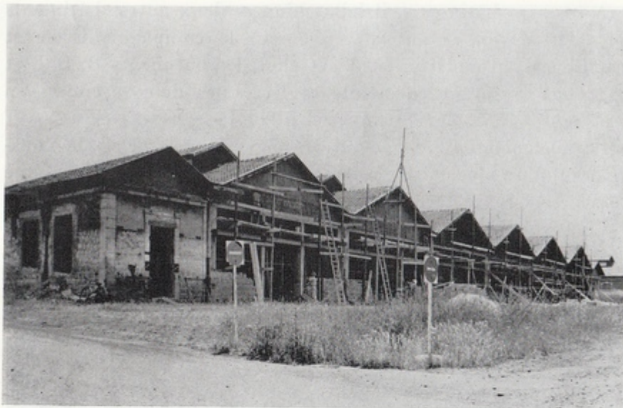
Fig. 5. — Réfection en cours des anciennes écuries, en atelier auto
