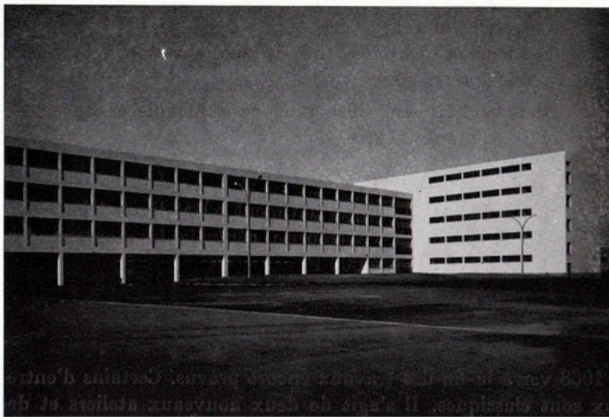
Fig. 12. — Le bâtiment d'instruction générale
