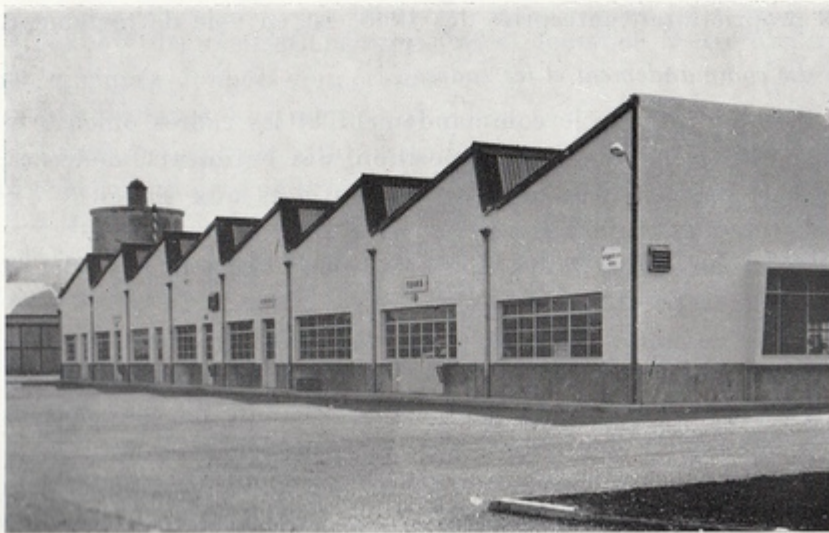
Fig. 7. — Bâtiment E7, atelier soudure, ajustage, tours
