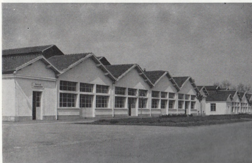
Fig. 6. — Réfection terminée des anciennes écuries, en atelier auto
