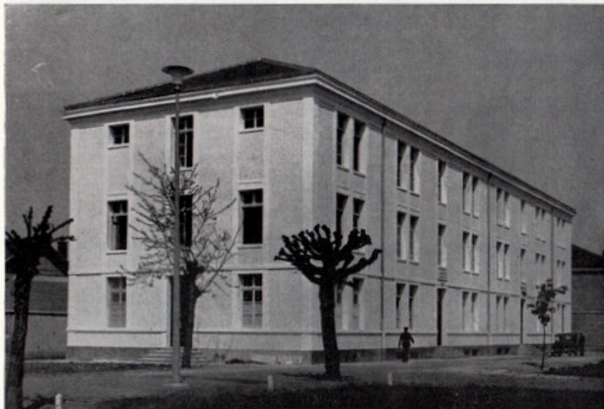
Fig. 4. — Un des trois bâtiments troupe construits
